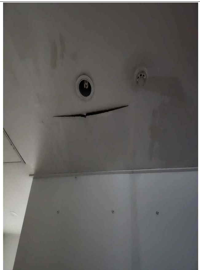
옥상 방수 노후화로 건물 내부 누수 발생
